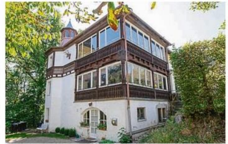
Fast zum Abriss freigegeben: die alte Villa auf dem Grundstück Krapfberg 5 in Gauting, einst Sitz der Tafel. Eine mögliche Neubebauung wird wohl im Rat Thema. FOTO: ANDREA JAKSCH
